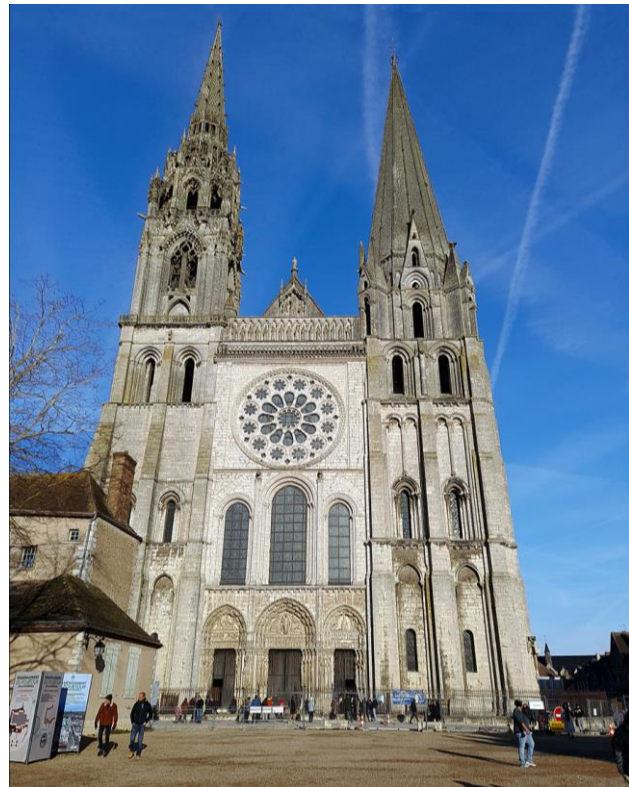
Fațada dinspre vest*
